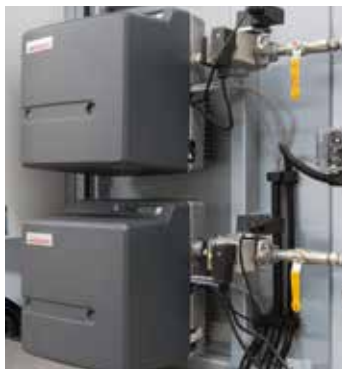
Quemador de gas para el calentamiento del horno y el sistema de postcombustión térmica
