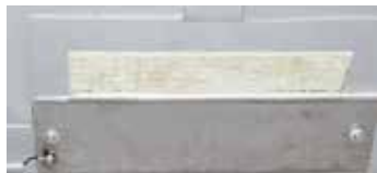
Aviso de rotura de crisol por debajo del salida de emergencia de un horno de fusión
