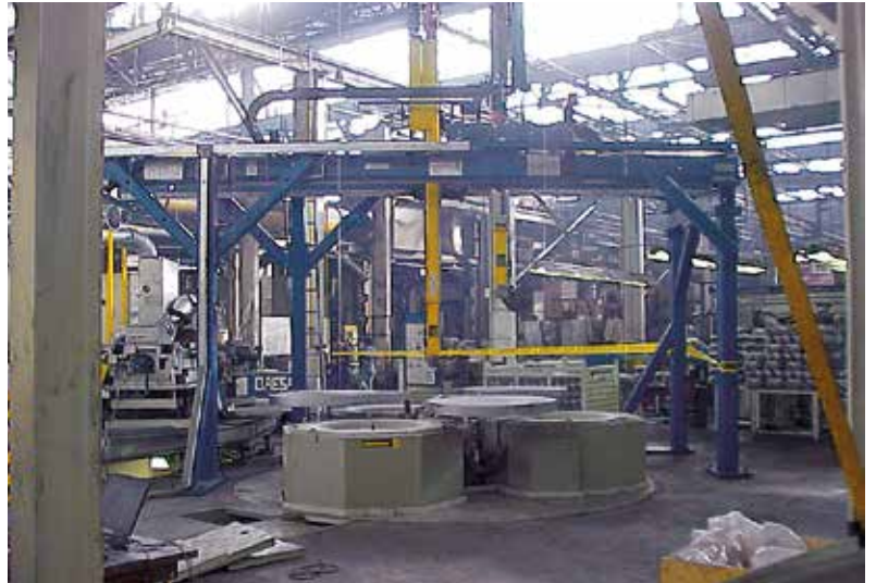
Instalación de mesa giratoria con 3 x T 150/11
