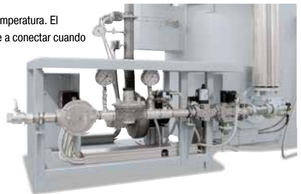
Quemadores con tramo de gas
